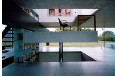
Resim 3. Hidrolik Platform Asansör (URL 2)
